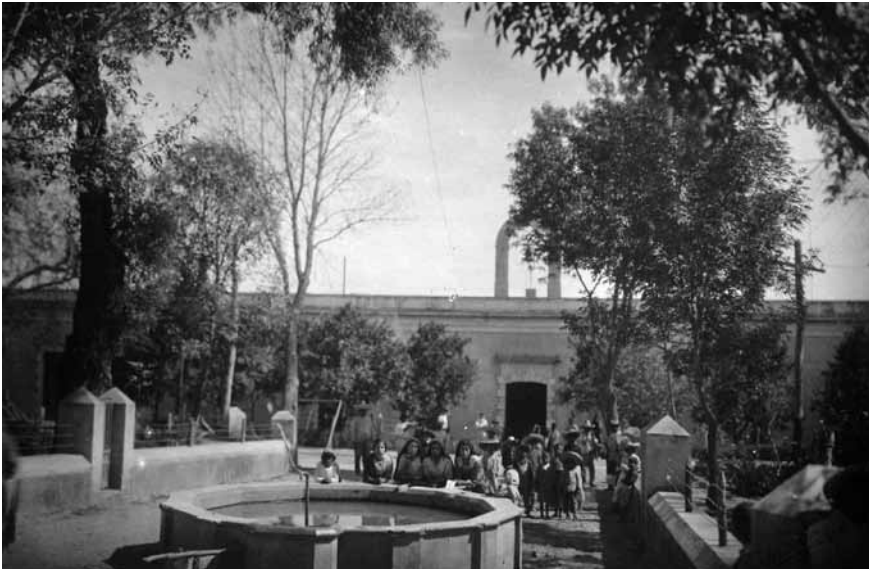
Mujeres y niños en el patio de la fábrica de Río Grande (El Salto) saliendo de la fábrica. Foto: sin firma.
