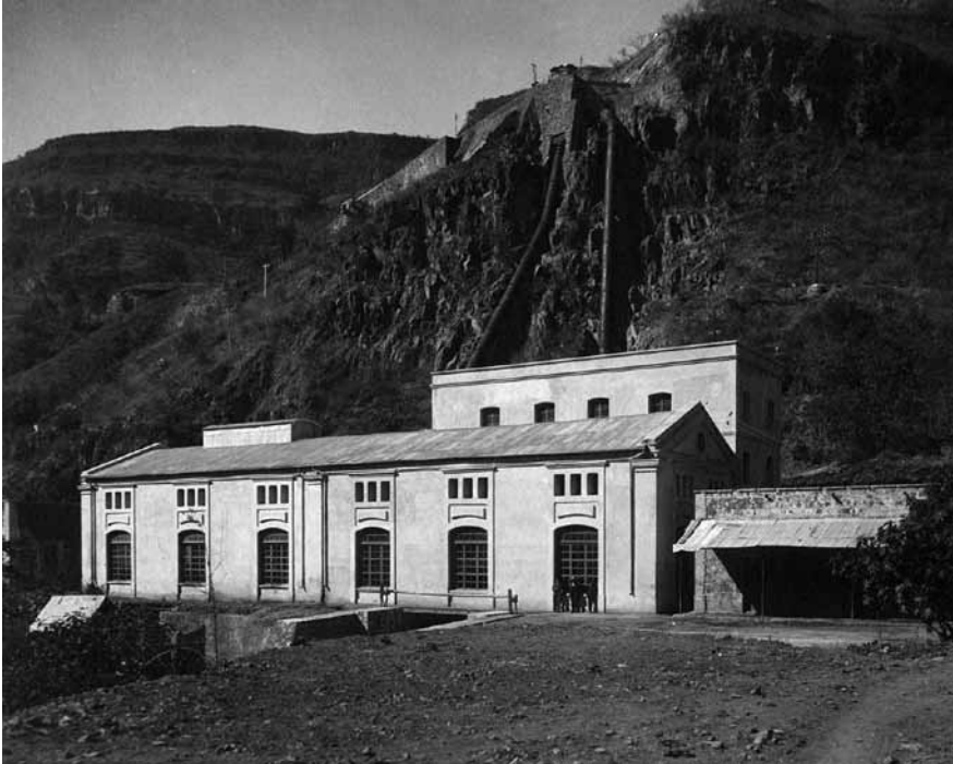
Edificio de la Planta Hidroeléctrica.
