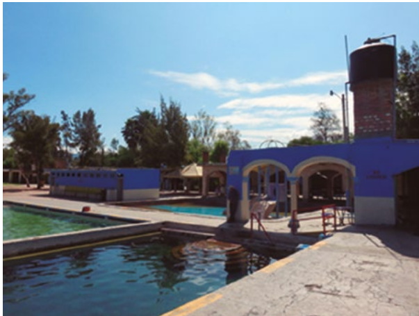
Figura 2. Perspectiva de uno de los balnearios más antiguos fuera de la zona de protección. Baños San Antonio. Perteneciente a la antigua Hacienda de San Isidro Mazatepec. De acuerdo con los habitantes, aquí solía acudir Porfirio Díaz. Hoy forma parte del Ejido San Isidro Mazatepec quienes se encargan de su gestión como empresa turístico-recreativa. Fuente. Trabajo de campo, realizado durante los meses de febrero de 2015-marzo de 2016. Foto Lucía González Torreros.
