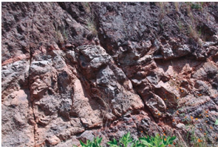
Figura 6. Falla de trazo NE-SO, corta la secuencia volcánica al sur de la sierra de La Primavera. Foto: Luis Valdivia Ornelas.
