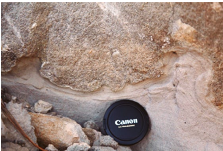
Figura 39. Intrusiones (diápiros) asociadas con cargas diferenciales o movimientos sísmicos, genera lo que se llama contacto en orlas. Foto: Luis Valdivia Ornelas.
